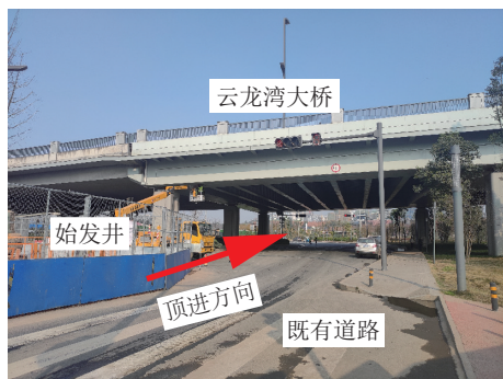
图2 施工场地周围情况
