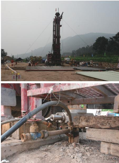
图3 2009年寄生管法欠平衡水平井施工现场
