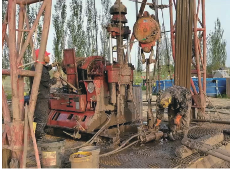
图1 XY-5型钻机进行铀矿施工
