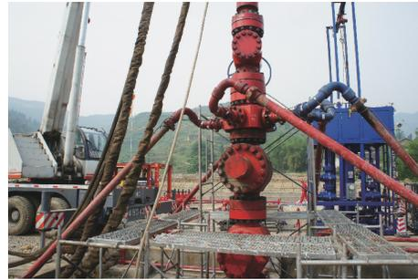
(a)改进前的压裂管汇结构
