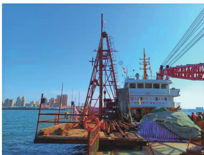
图4 钻探船施工现场
