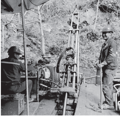
图2 HTZB-500C型便携式全液压岩心钻机施工
