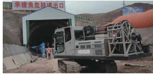
图7 川藏铁路贡觉隧道施工
