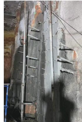
图8 超前小导管注浆施工现场
