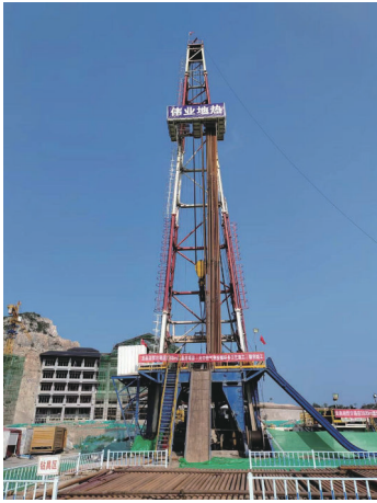
图2 LQDR-1地热温泉井施工现场
