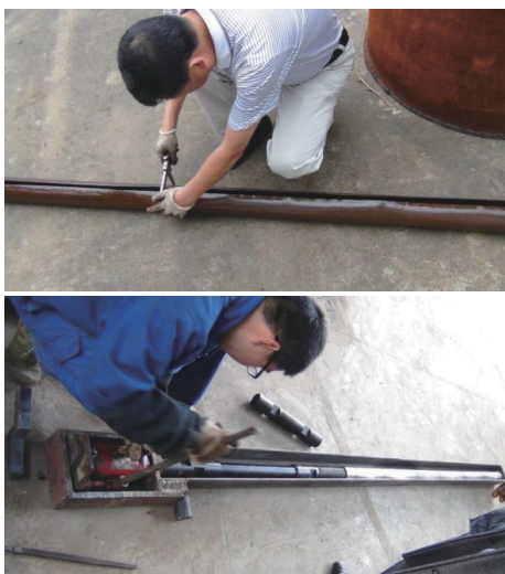
图6 膨胀管的制作与安装
