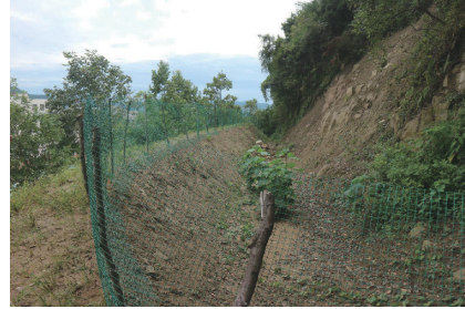
图9 拦石堤、落石槽
