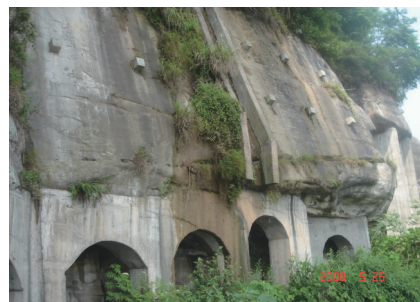
图8 支撑墙+锚固+排水
