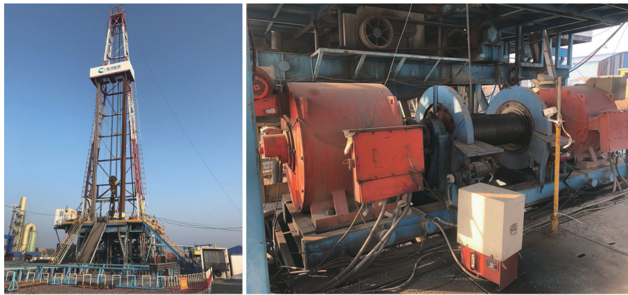
图5 现场施工应用
