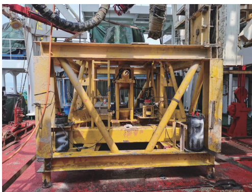
图8 电池分配器安装
