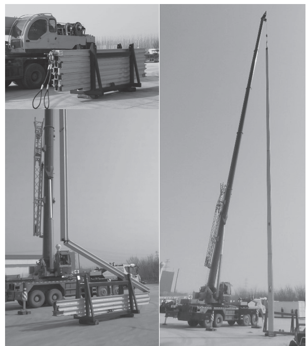
图10 导轨施工提升过程
