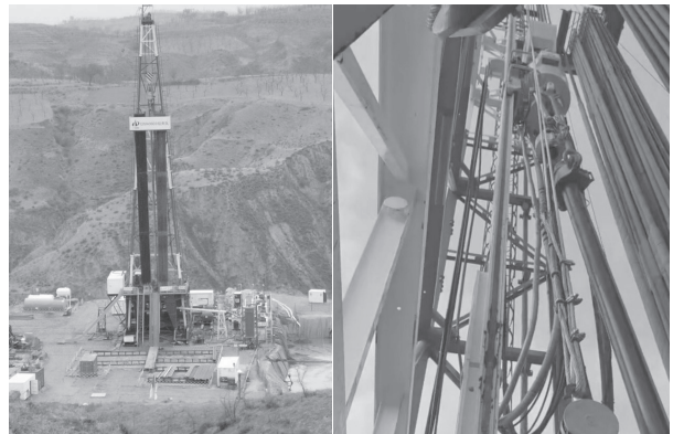
图9 现场施工图片
