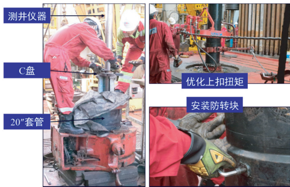
图 2 下入“人造”封隔层
