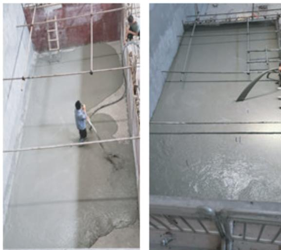
图4 泡沫轻质土加筋路堤浇筑过程
