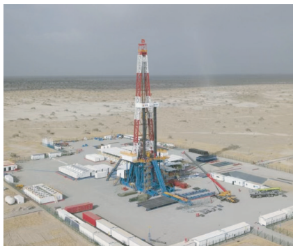
图10 钻机在深地塔科1井作业
