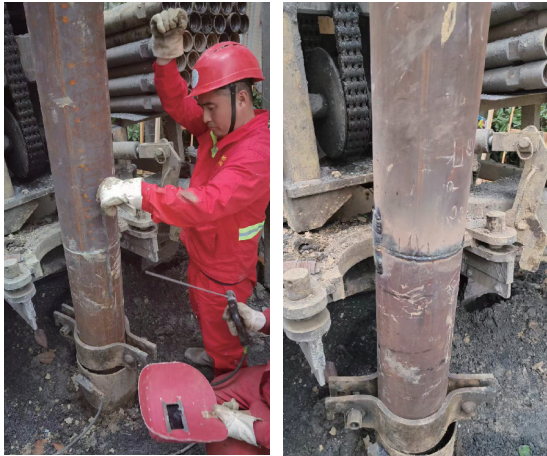
图4 楔型焊接+肋骨固强长套管
