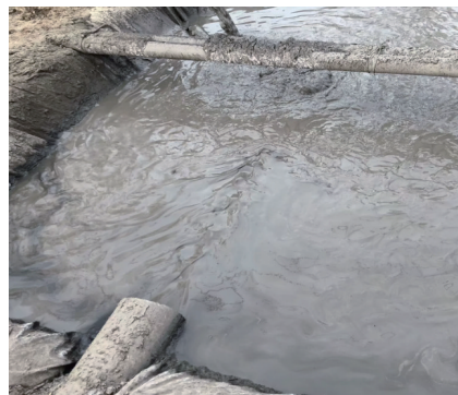
图6 易降解强抑制防塌冲洗液现场使用情况
