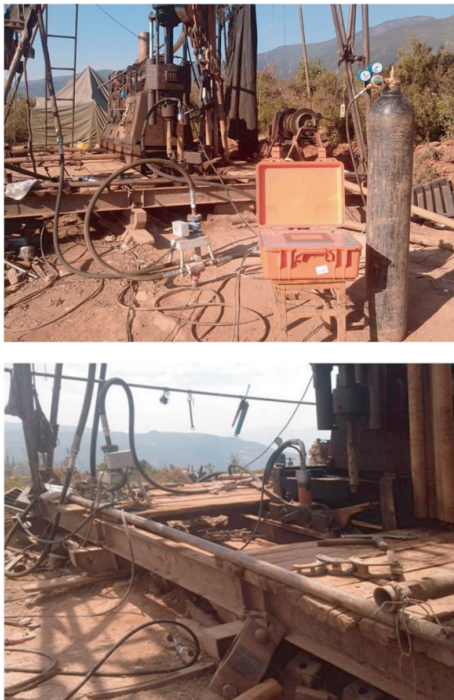
图 4 云南某引水工程随钻压水试验现场
