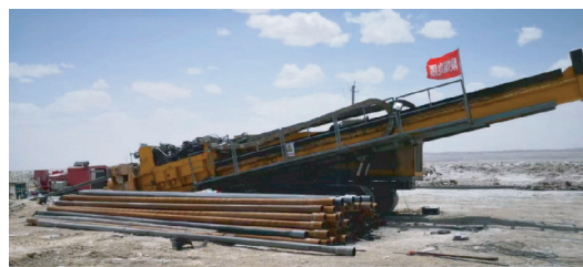
图4 GBS-320型水平定向钻机在青海冷湖施工现场
