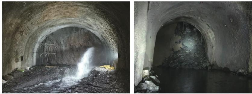
(a)KS82+145.5处超前探水孔涌水 (b)KS82+177处涌水从塌方体下部渗出
