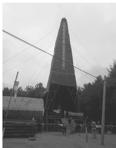
图 1 皖南地 1 井钻探施工现场
