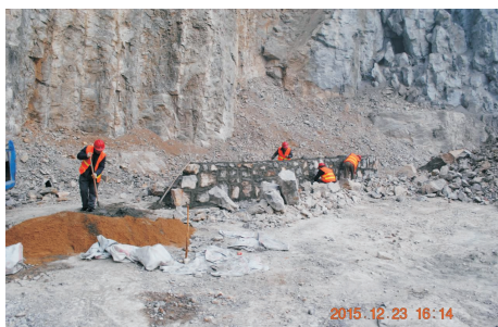
图8 挡石墙砌筑
