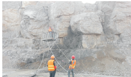
图 5 坡面喷面
