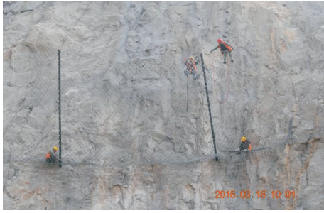
图 7 被动防护网施工
