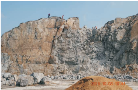
图 3 坡面危石撬除
