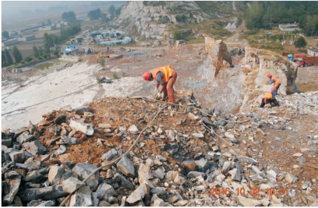
图 2 坡顶削坡排险施工
