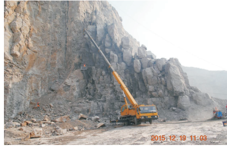
图 4 裂隙勾缝注浆
