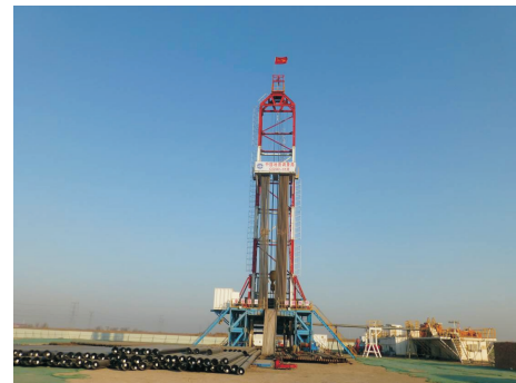
图 10 CGSD-01 井施工现场
