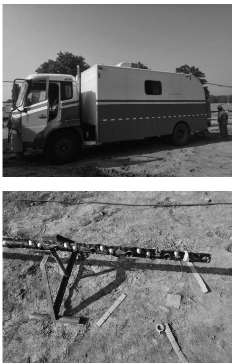
图2 射井车施工及射井弹夹照片
