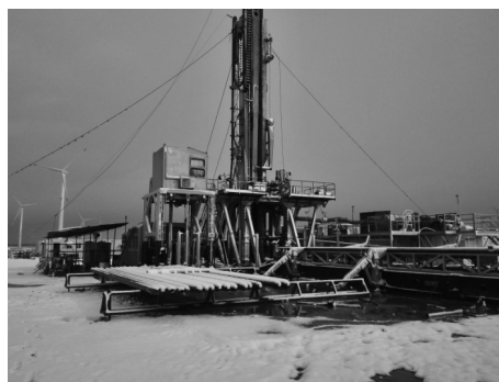
图6 CMD180T型钻机施工
