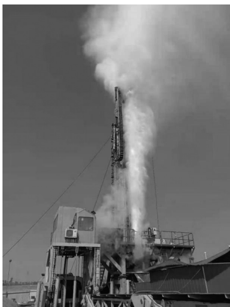
图5 CMD150T型钻机天津施工
