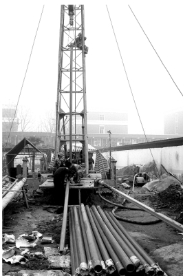
图 4 监测井下管现场
