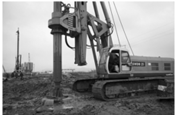
旋挖钻机施工现场
