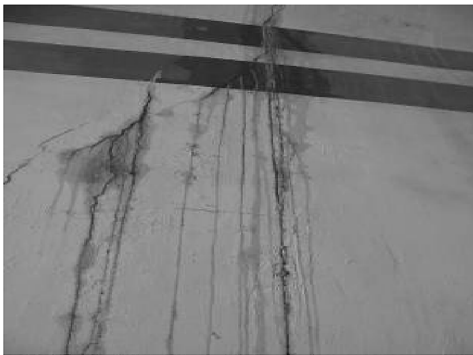
图5 中隔墙裂缝
