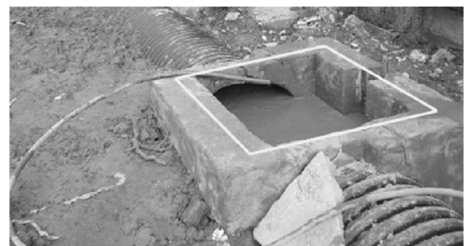
图 2 排水井砌筑方式示意图
