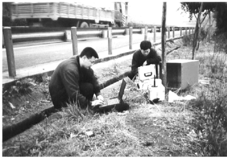
图 6 内宜路现场数传电台调试情况
