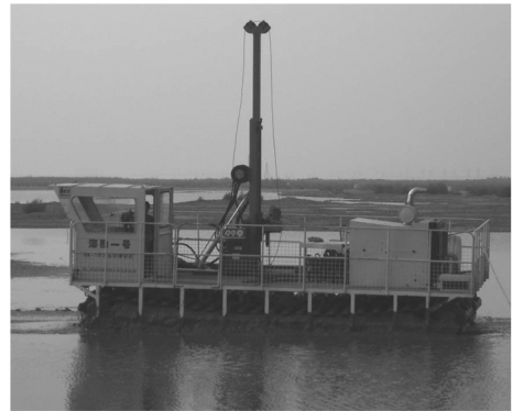
图2 “海勘一号”钻机在青岛海湾大桥施工区附近的滩涂地进行钻探试验
