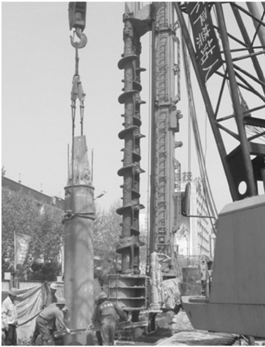
图2 沉桩施工
