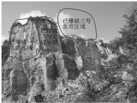
图7 1、2、3号危岩爆破后
