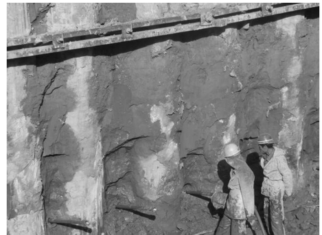
图 3 注浆施工效果图
