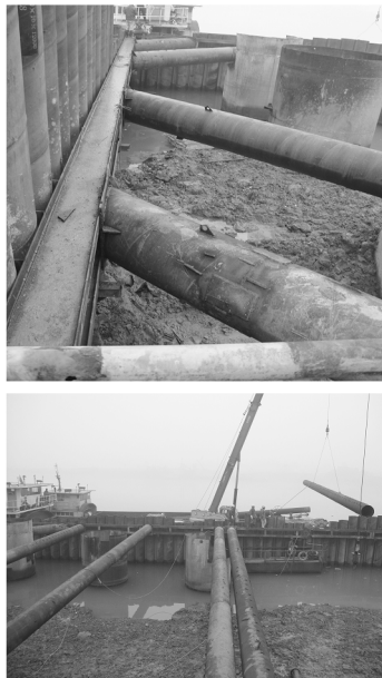
图 5 围堰内支撑的设置
