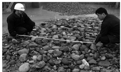
图 2 宜昌盾构施工中从江底取出的卵石
