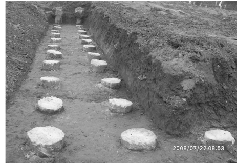
图 2 截桩后的现场图片
