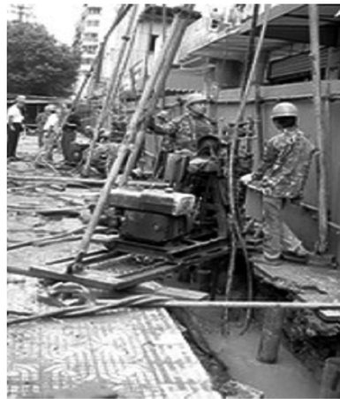
图1 XY-100型小型勘察钻机施工钢管微桩
