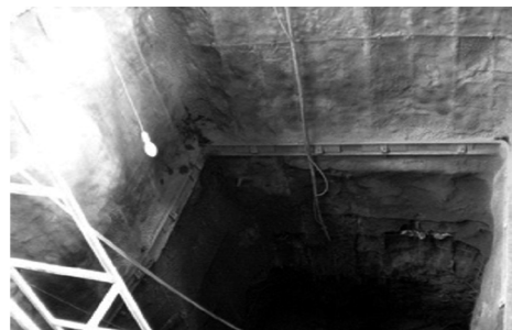
图3 预应力锚杆锁定在槽钢横梁上
