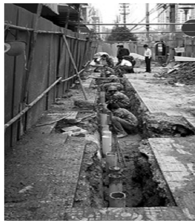
图2 钢管微桩施工结束后施工桩顶连梁
