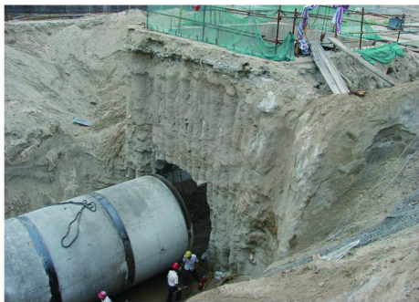
图1 旋喷设备完成的西安市污水处理工程竖井成桩
