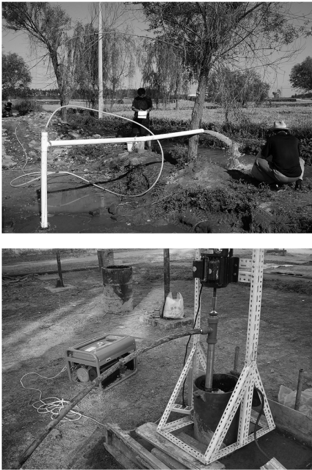
图3 监测井洗井现场
