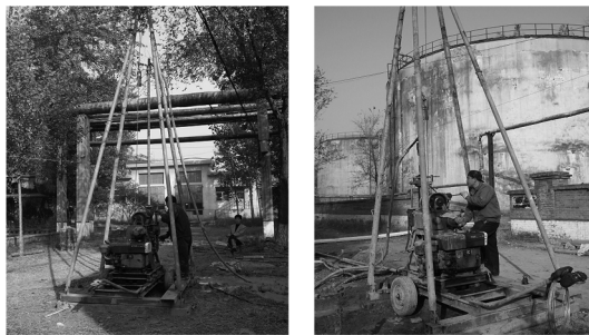
图1 某石油化工厂钻进施工现场
