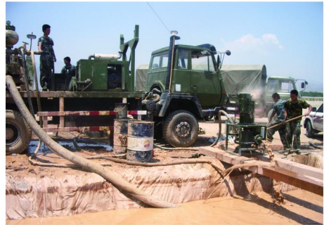
图4 快速造浆机现场使用
