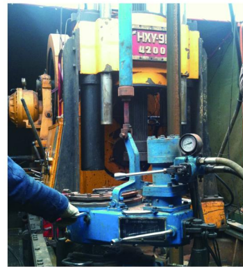
图8 山东地勘局第三地质大队 4000 m 钻孔现场
