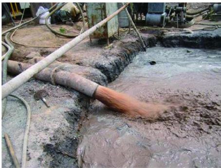
图6 孔内气、水、渣混合物通过捕尘装置定点排放
