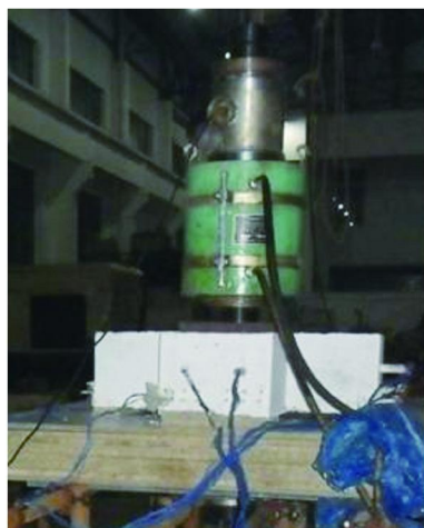
图 3 锚索张拉现场
