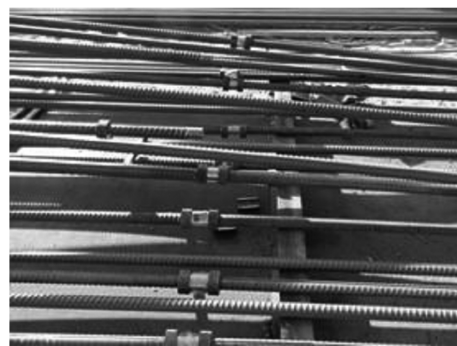
图5 加工完成的分体式套筒连接钢筋
