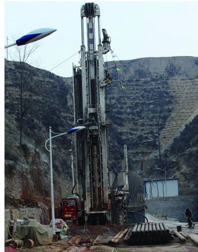
图7 通风孔施工现场
