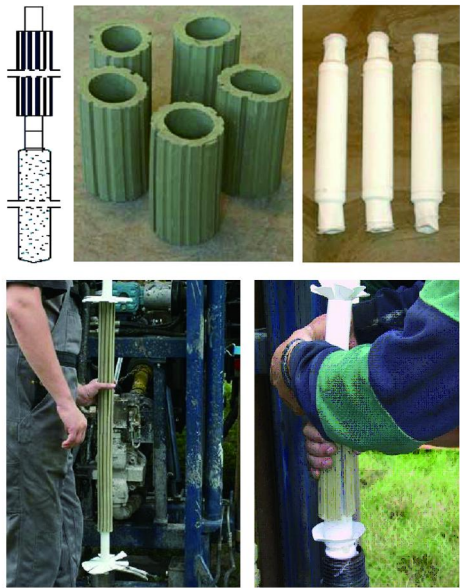
图15 连续多层监测井预制材料及安装
