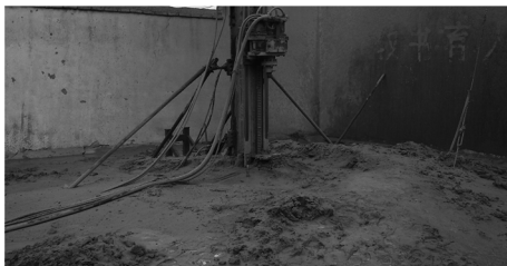
图 4 粉细砂地层钻进
